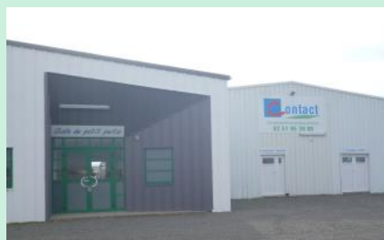
Rue du Puits Jouet ILE D'Olonne
